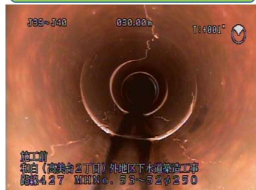
管更生施工前
