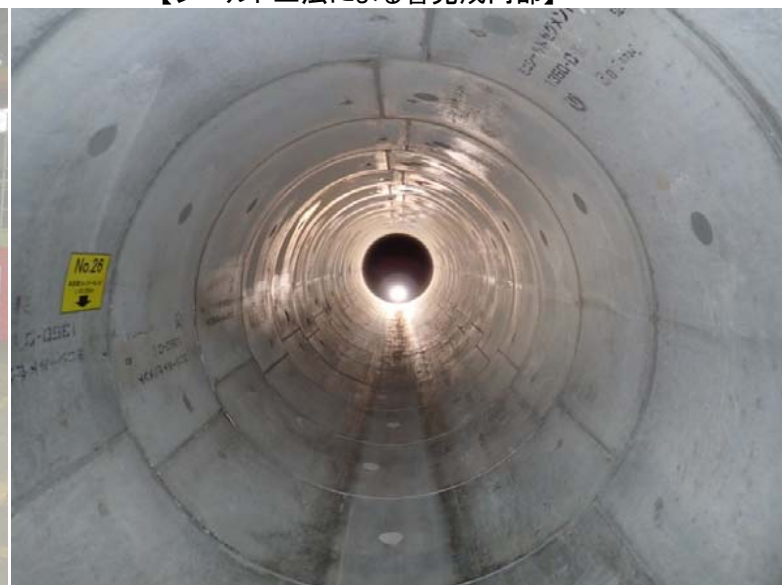
【シールド工法による管完成内部】
